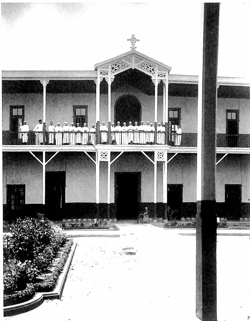
Construcción de adobe y madera de dos pisos, con corredores típicos de la arquitectura colonial. Destacan amplios patios con hermosos jardines muy bien cuidados. En el segundo piso se ven funcionarios de esa época.
